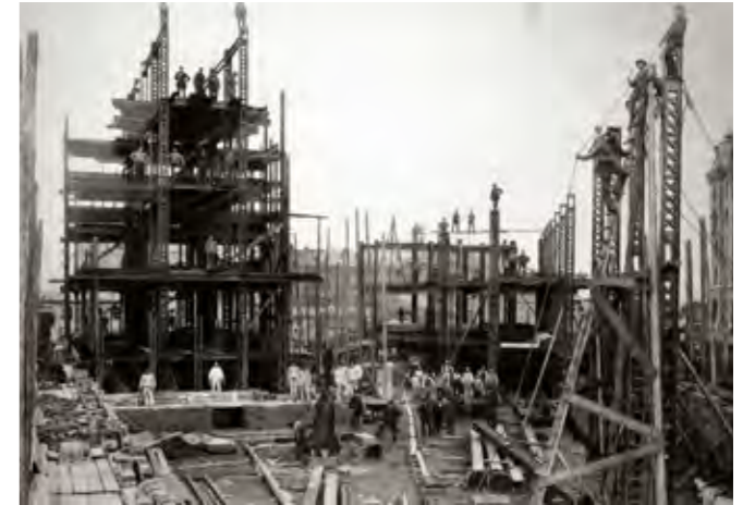
Für den Bau des Speicherblocks H in der entstehenden Speicherstadt werden Eisenträger hochgezogen. Bauarbeiter nutzen einfach zusammen genagelte Holzleitern zum Besteigen der Großbaustelle, und per Handwagen kann Baumaterial über provisorische Gleise transportiert werden.
